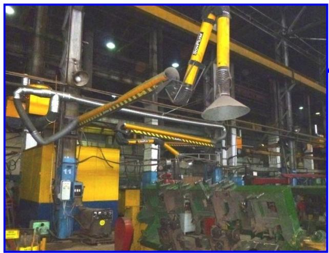
Установлены местные вытяжные фильтровентиляционные установки в количестве восьми штук, заменены системы воздухопроводов и вентиляции на двух окрасочных камерах.
