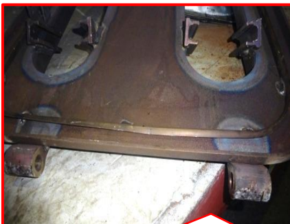
Деформация приварных элементов
