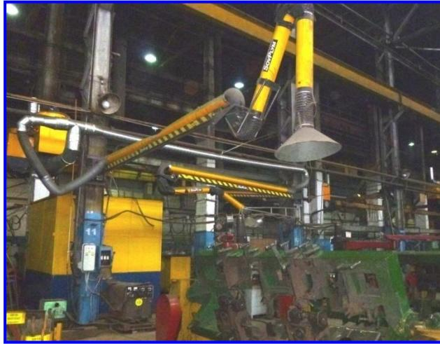
Установлены местные вытяжные фильтровентиляционные установки в количестве восьми штук, заменены системы воздуховодов и вентиляции на двух окрасочных камерах.
